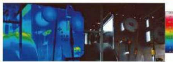
施工後の状態 (放射率 1.0 の熱画像)
